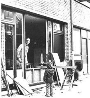
Vivienda modificada para poder ingresar en silla de ruedas
